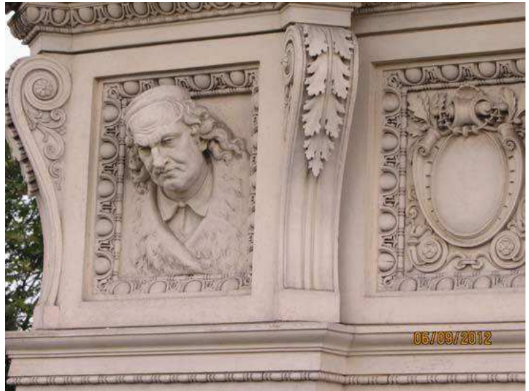
^ Fries: Büsten an den Gebäudeecken
