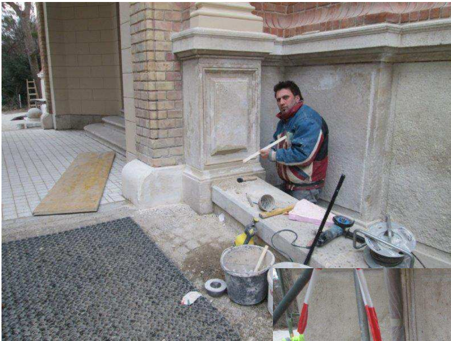
Arbeiten am Anschlussbereich des Gebäudesockels mit der äußeren Rampeneinfassung >
