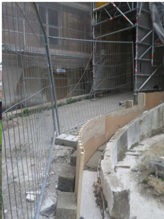
Wiederaufbau der Rampeneinfassung >
