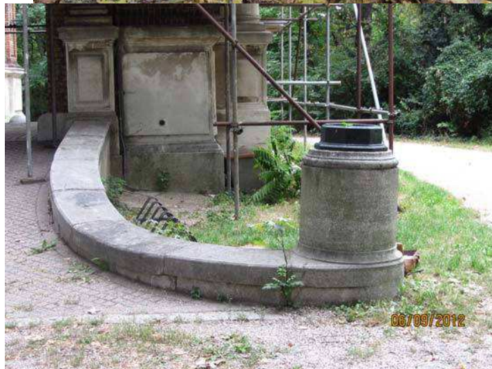
^ zylinderförmiger, größerer End-Pylon, jeweils am äußeren Brüstungsende
