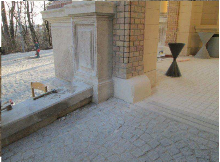
fertig gestellte Kopfsteinpflasterung der Rampenauffahrt, sowie Wienerbergerpflaster in der Vorhalle >
