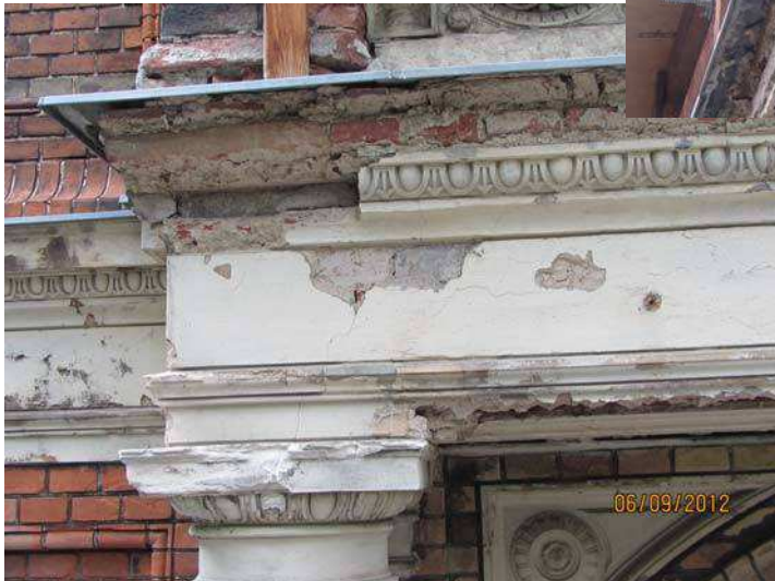
Balkon_südseitig > desolate Balkonbrüstung
