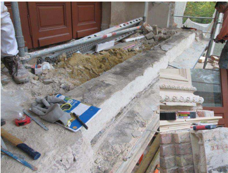
Wiederaufbau der Balkonbrüstung >
