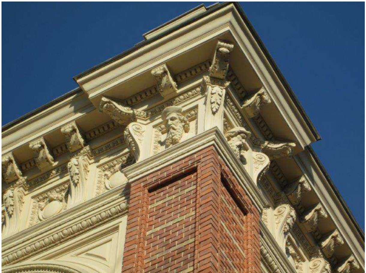
^ Hauptgesimse und Fries / Gebäudeecke nach Fertigstellung
