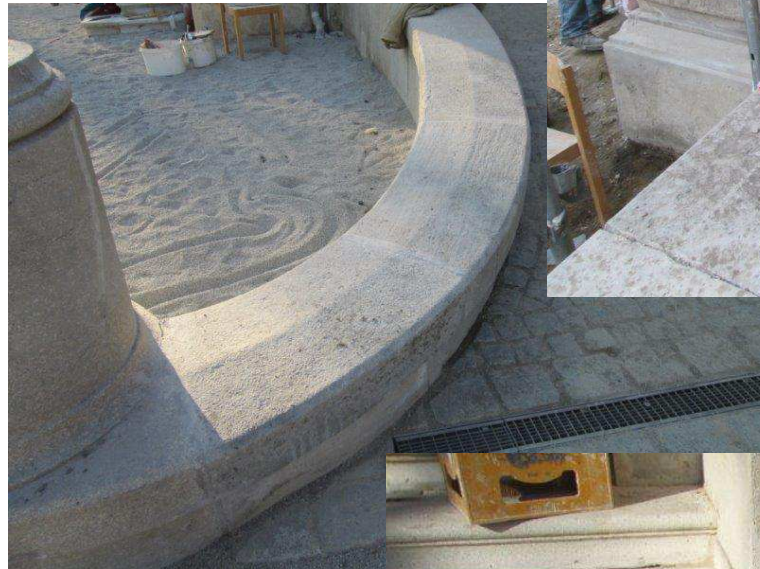
Arbeiten am Anschlussbereich des Gebäudesockels mit der äußeren Rampeneinfassung >
