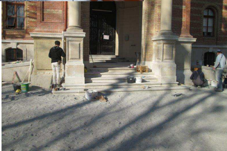
< Eingangsbereich_süd Sockelzone und Treppen zur Vorhalle
