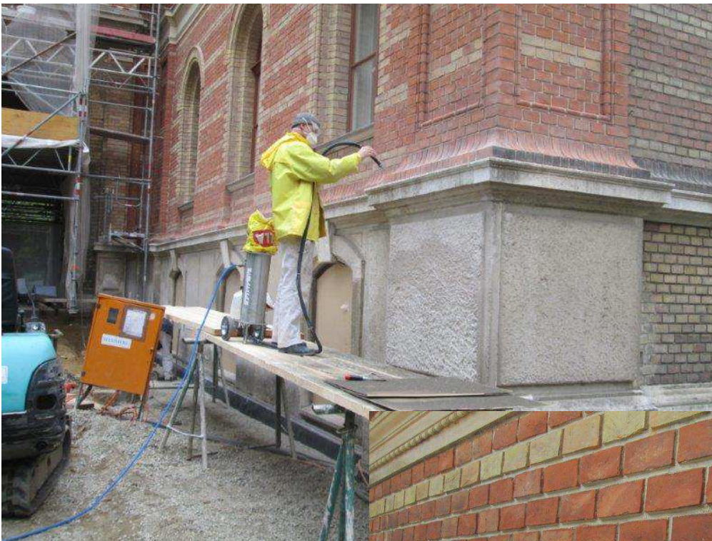
^ Reinigungsarbeiten (im Niederdruckstrahlverfahren)
