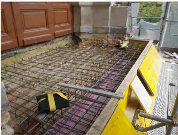
^ Herstellen der Balkonplatte
