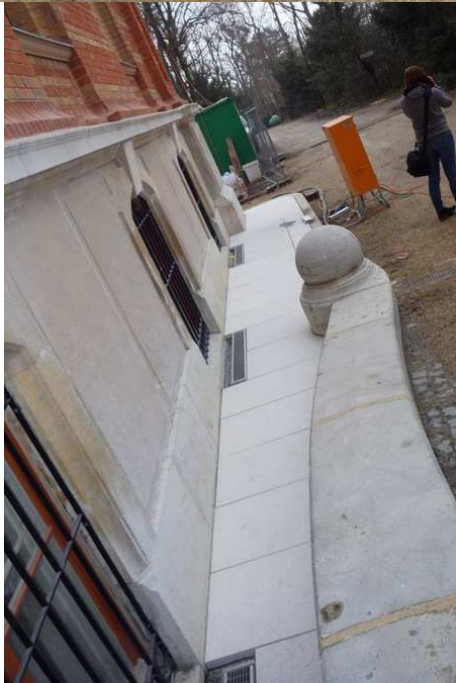
Ansichten links, unten und oben: Arbeiten und Ergebnis Pflasterung im Traufenbereich, sowie der inneren Rampeneinfassung
