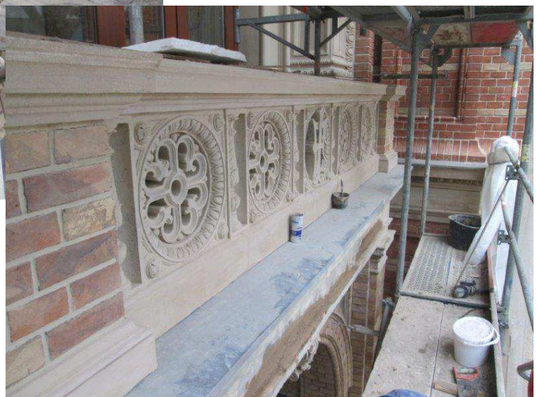
neu aufgebaute und fertig gestellte Brüstung >
