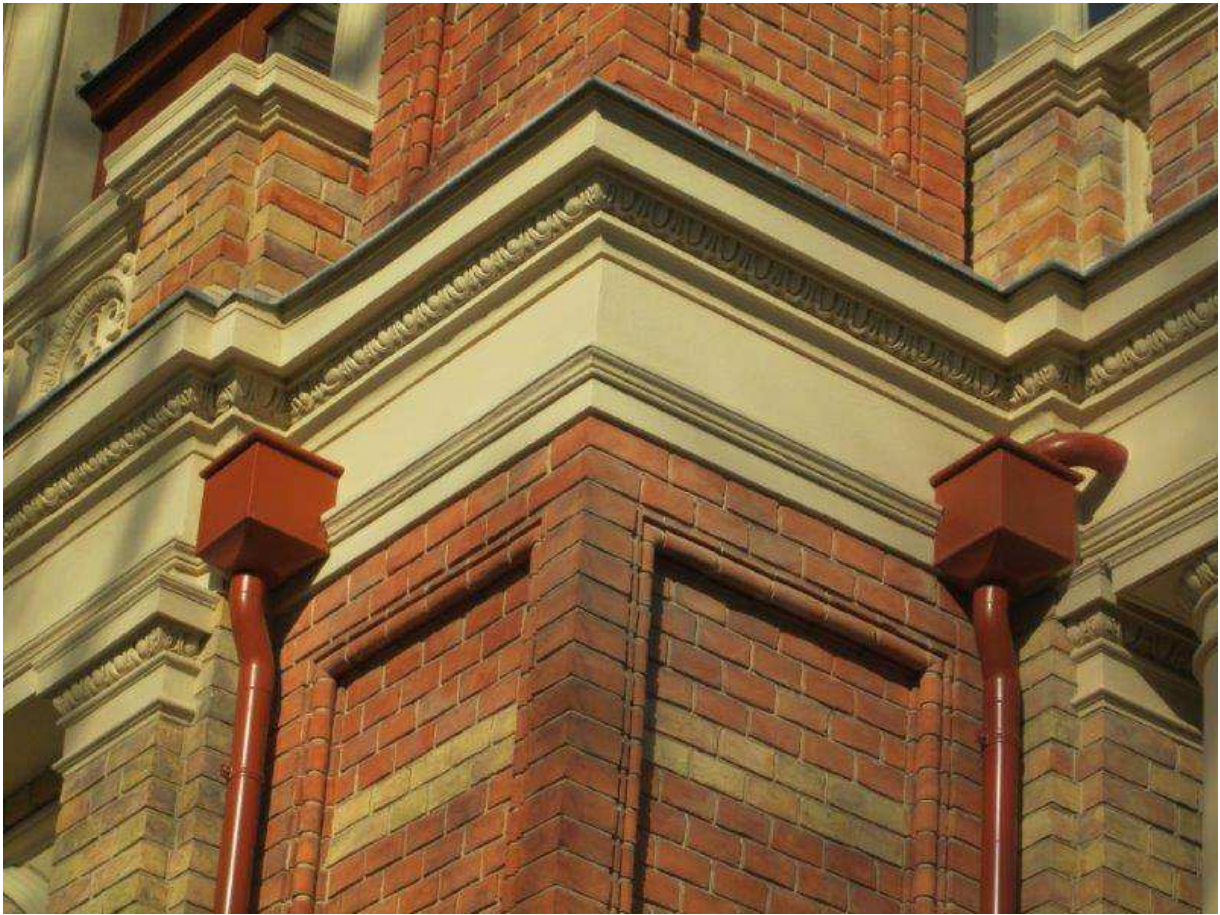
^ Kordongesimse / Gebäudeecke nach Fertigstellung
