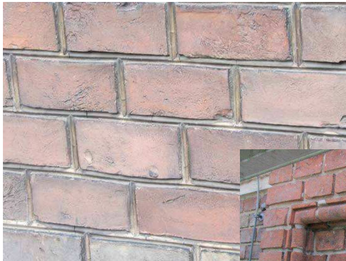
Seitliche Wandlisenen mit Formsteinen, desolate Fugen >
