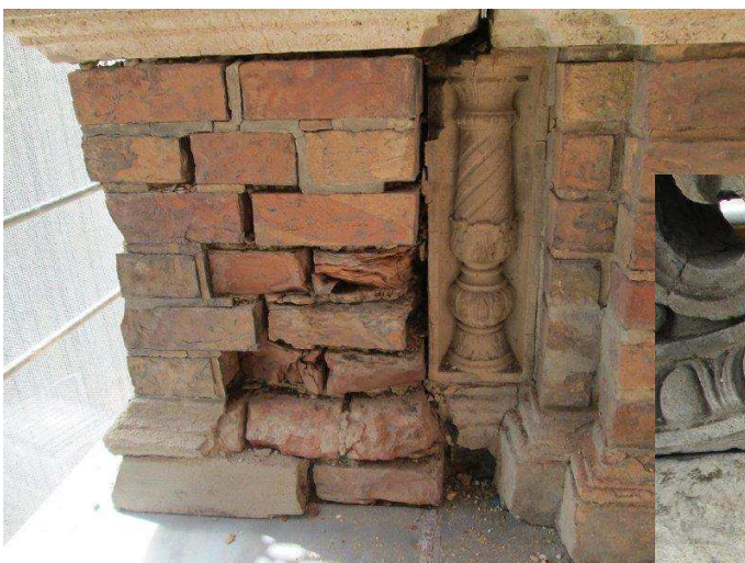
^ Ansichten nach der Reinigung: nach der Reinigung zeigte sich ein völlig desolates Bild: gebrochene Balustradenteile, kaputte, zerbröselnde Mauersteine bei den Eckpfeilern, offene, bindemittelschwache Fugen
