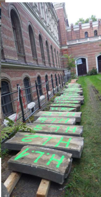
Wiederaufbau der Rampeneinfassung >
