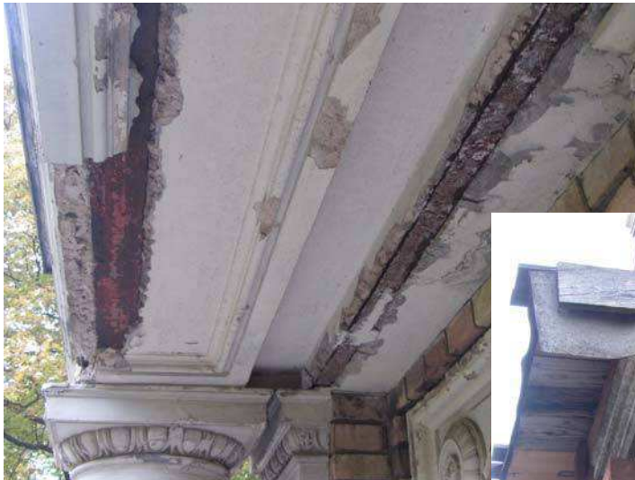
Balkon_südseitig > desolate Balkonbrüstung
