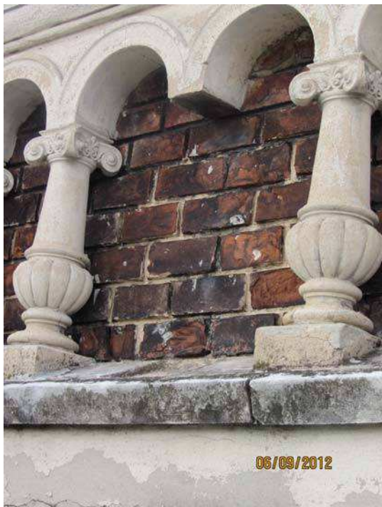
^ verschmutzte und beschädigte Sichtziegelverblendung >
