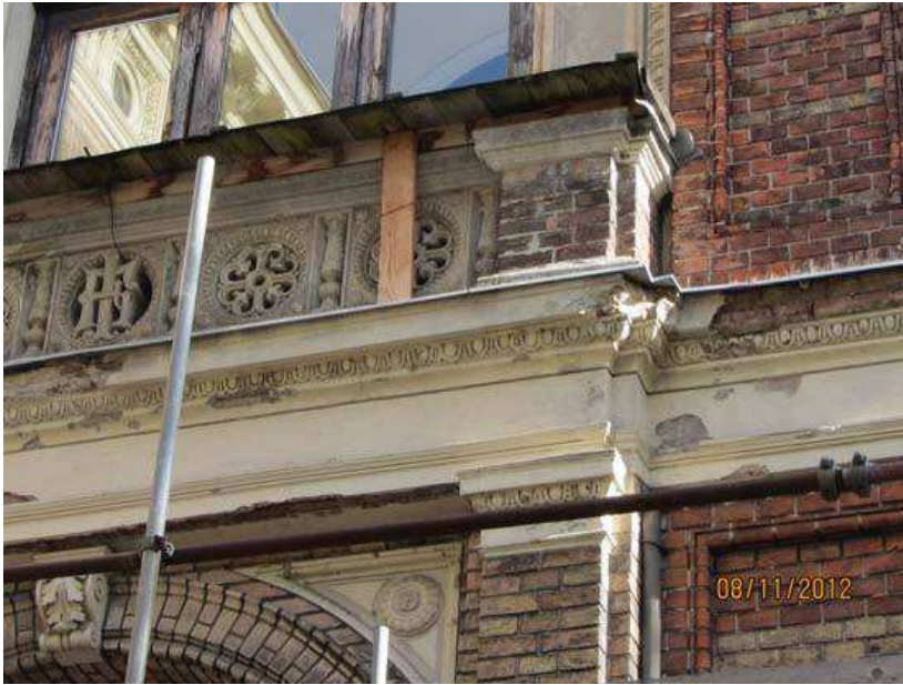
< Ost: Kordongesimse, Kapitell, Ornament im Zwickel bei Durchgang Frei liegender und angerosteter Eisenträger an der Balkonuntersicht
