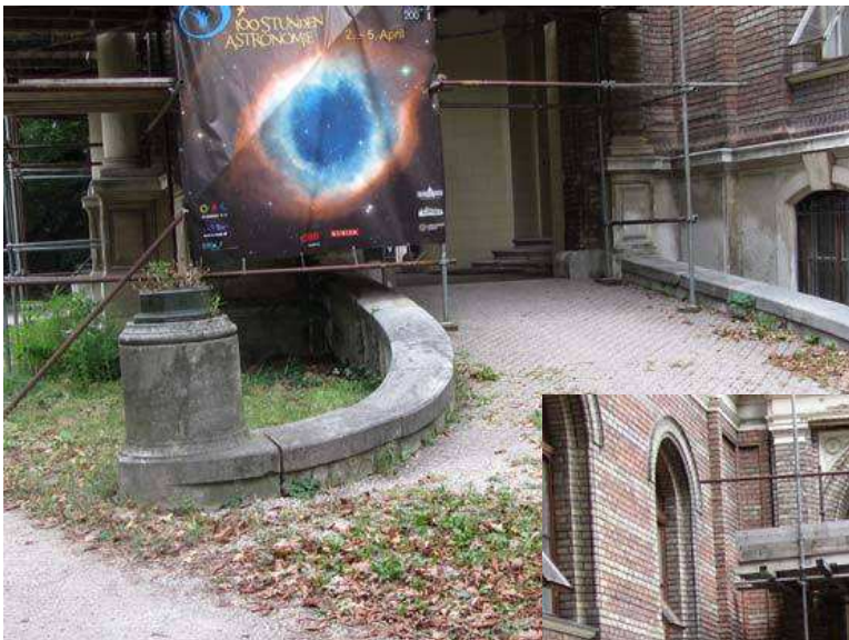
Rampenanlage mit gekrümmtem Verlauf, seitlichen niedrigen Brüstungen aus Naturstein, Belag mit Würfelsteinen (Granit).
