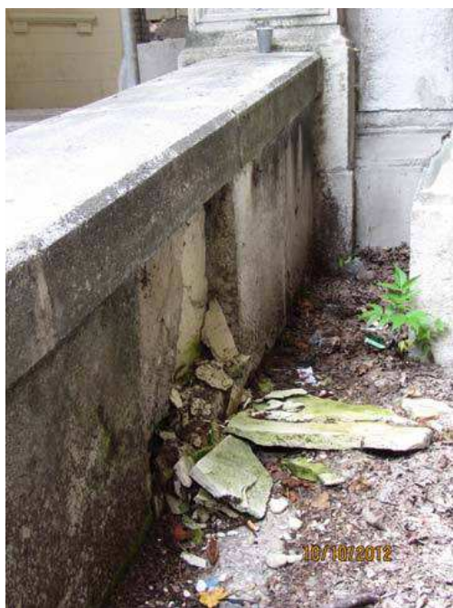
^ Verplattung der Brüstungswangen
