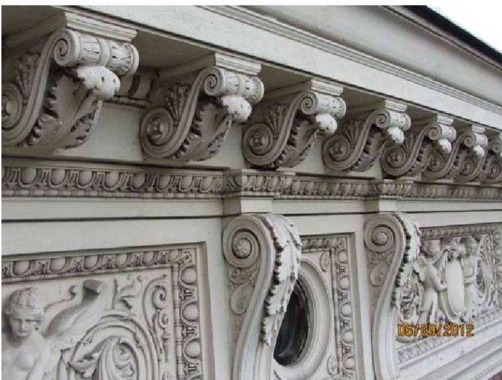
< Konsolen aus Romanzement ohne tragende Funktion
