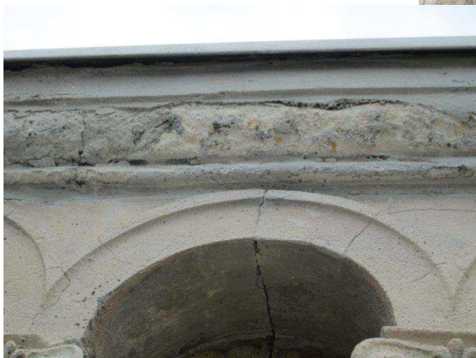
^ verschmutzte und beschädigte Sichtziegelverblendung >
