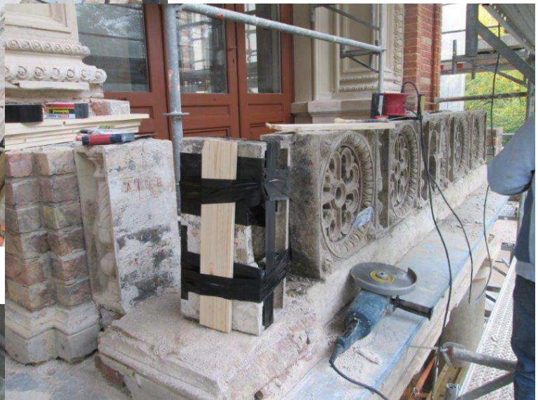
Wiederaufbau der Balkonbrüstung >
