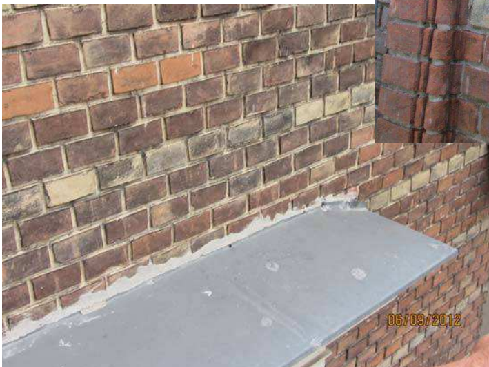
Seitliche Wandlisenen mit Formsteinen, desolate Fugen >
