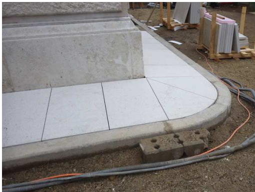
^ Eckansicht der Traufenpflasterung
