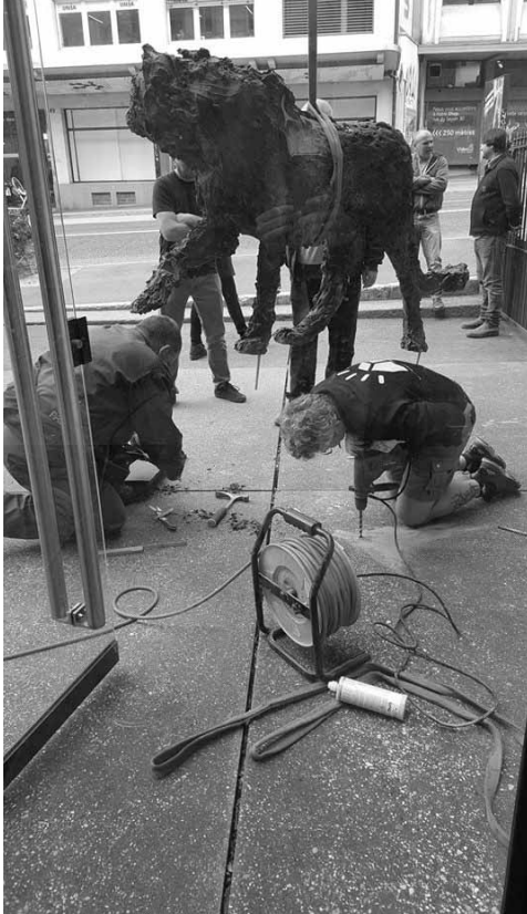
Installation des guépards de Davide Rivalta.
