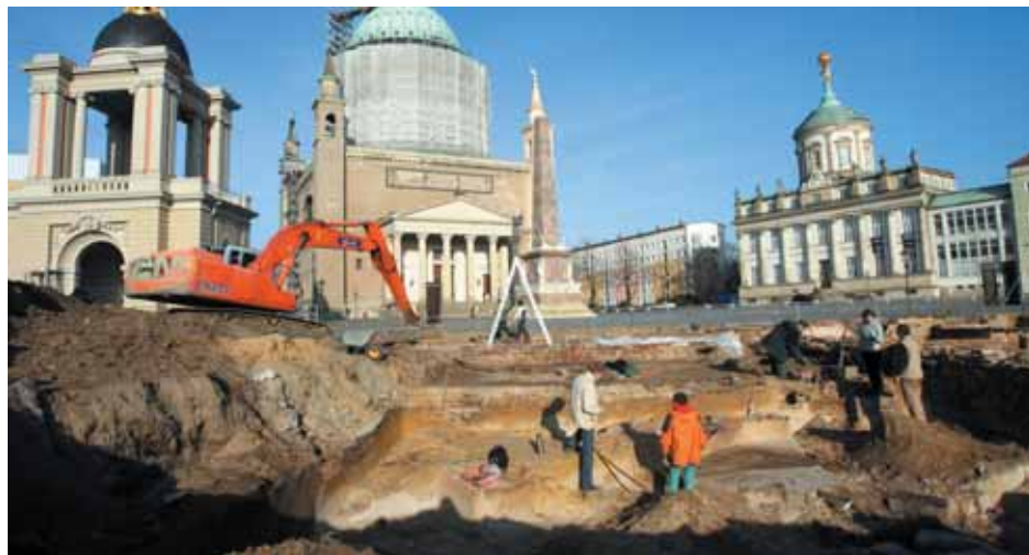
Bislang steht nur das von TV-Moderator Günther Jauch gestiftete „Fortuna-portal“ (li.): 20-Millionen-Spende macht den Weg frei für den Wiederaufbau des Potsdamer Stadtschlösses.
